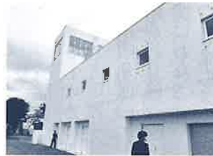
◀防災センター
